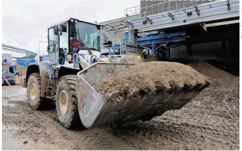
Das alternative Rohmaterial wird für den Transport nach Wildegg auf LKW geladen.
