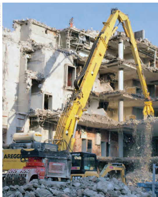
Rückbau eines Wohnhauses: Die Zeiten der Abrissbirne sind schon lange vorbei.
