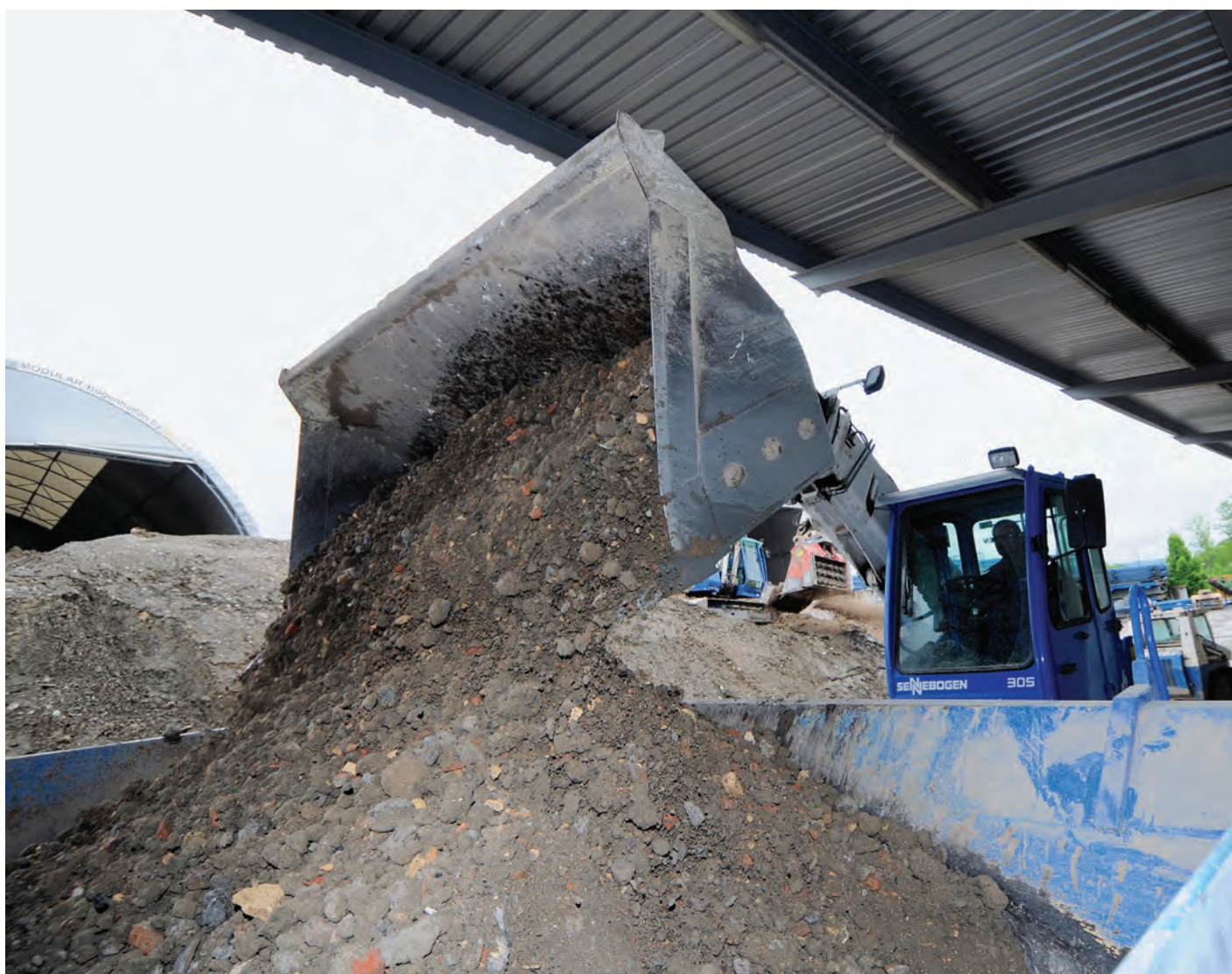
Das Rückbaumaterial wird für die Aufbereitung auf ein Förderband gekippt.
