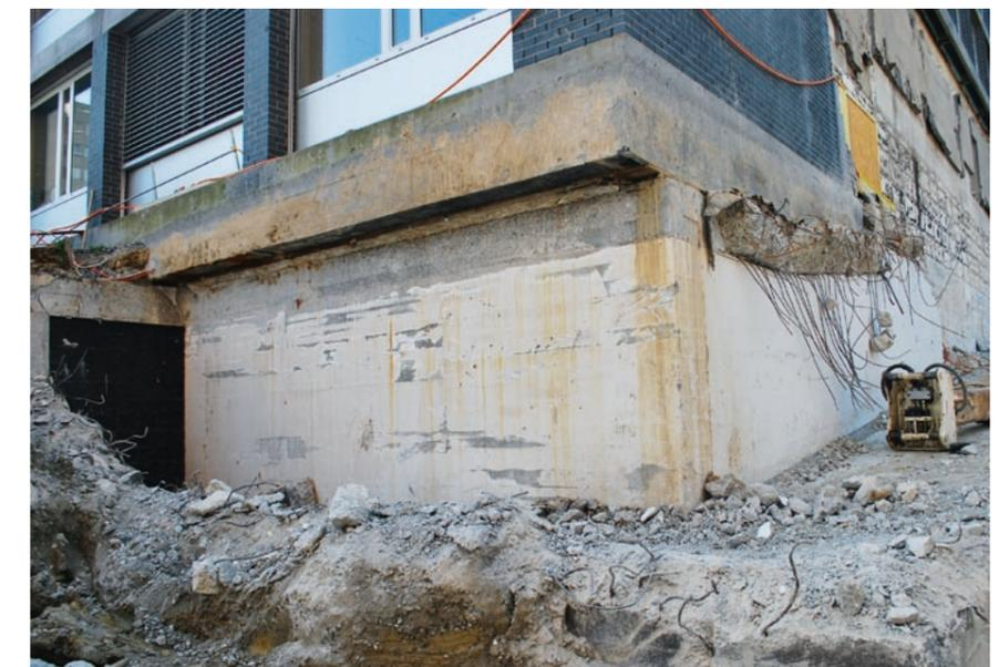
Die eingeklemmte Wand lässt sich nicht einfach abbrechen. Sie steckt zwischen dem Obergeschoss des Hauptgebäudes und dem Fundament.
