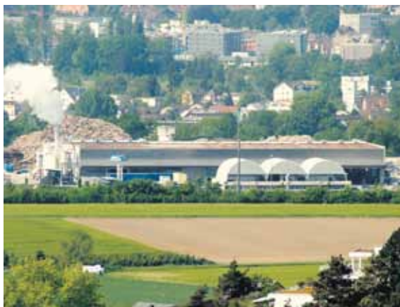
25 000 Tonnen Material werden pro Jahr verarbeitet. tp
